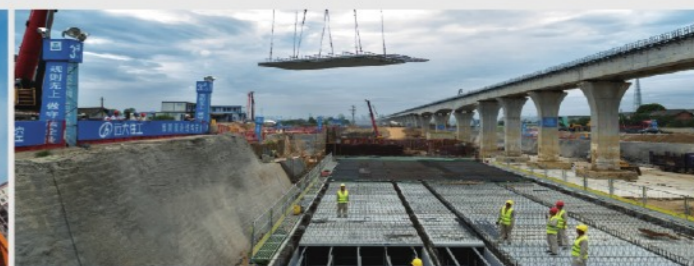
预制叠合装配整体式地下综合管廊
